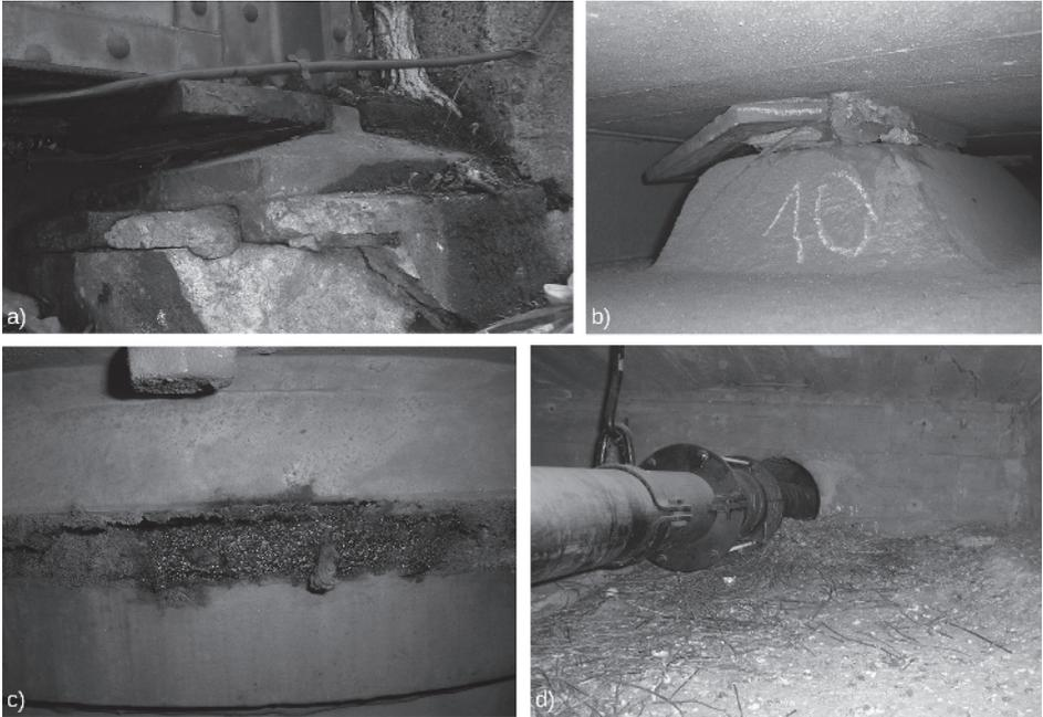
**Bild 5.** a) bis c) Beispiele für schadhafte Lager und Lagerpunkte, d) als Nistmöglichkeit genutzter Hohlraum einer Brücke mit Verschmutzungen durch Vogelkot und Nistmaterial (nach [13])
